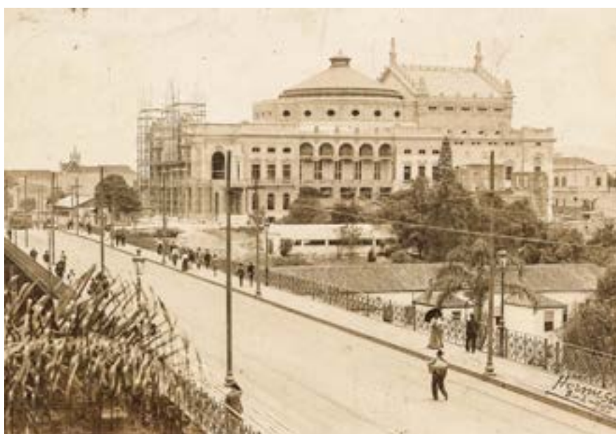
Foto: Theatro Municipal em construção
